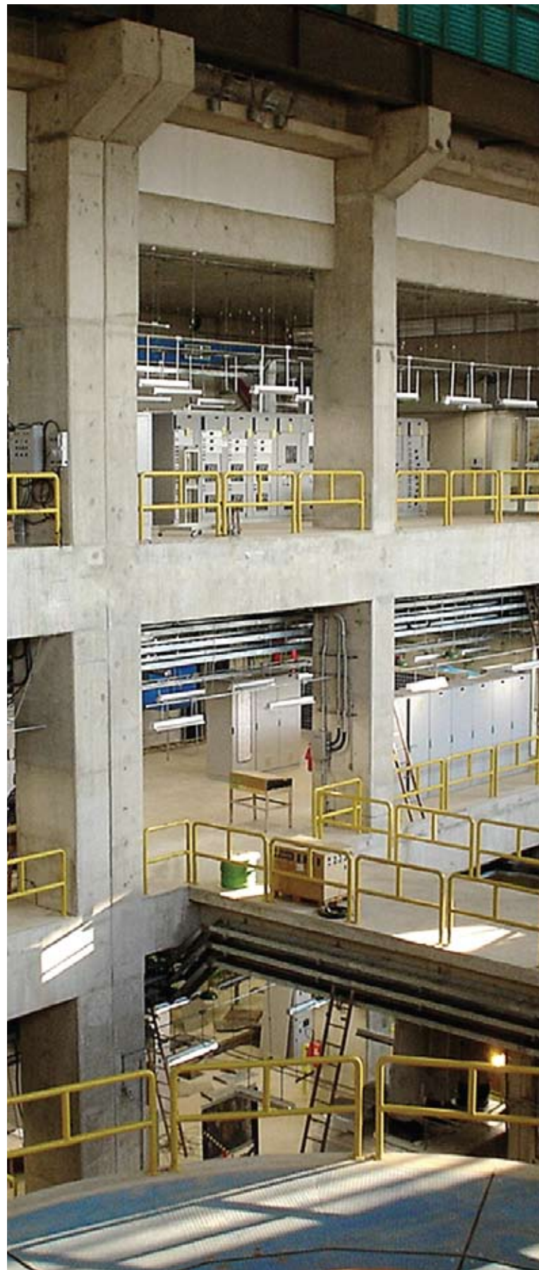
Casa de força - Usina hidrelétrica de Corumbá.
