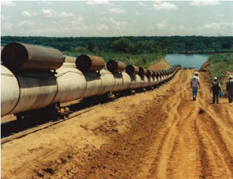
Construção do gasoduto Brasil-Bolívia.
